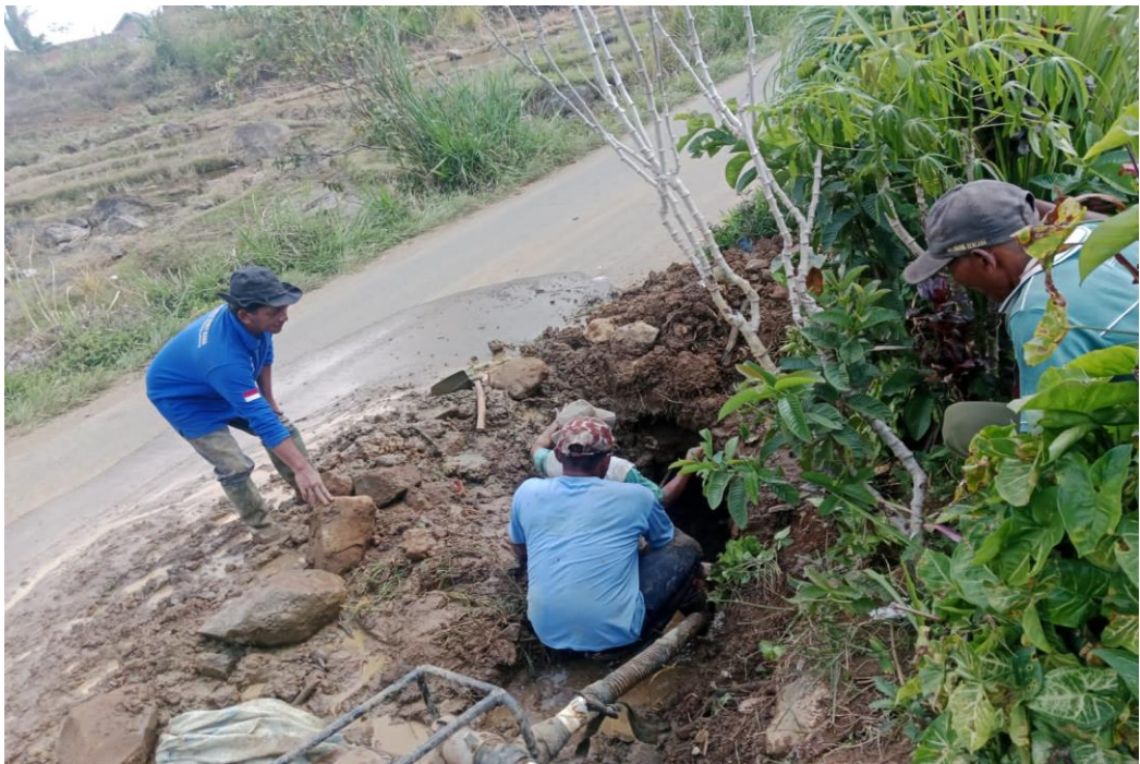
Gambar 1.4 Proses Pebaikan kerusakan pipa bocor
