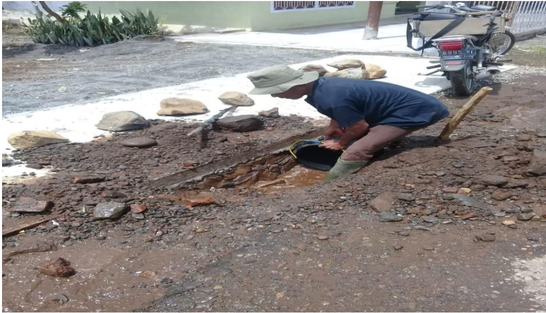
Gambar 1.5 Pemasangan PAM di Rumah Pelanggan
