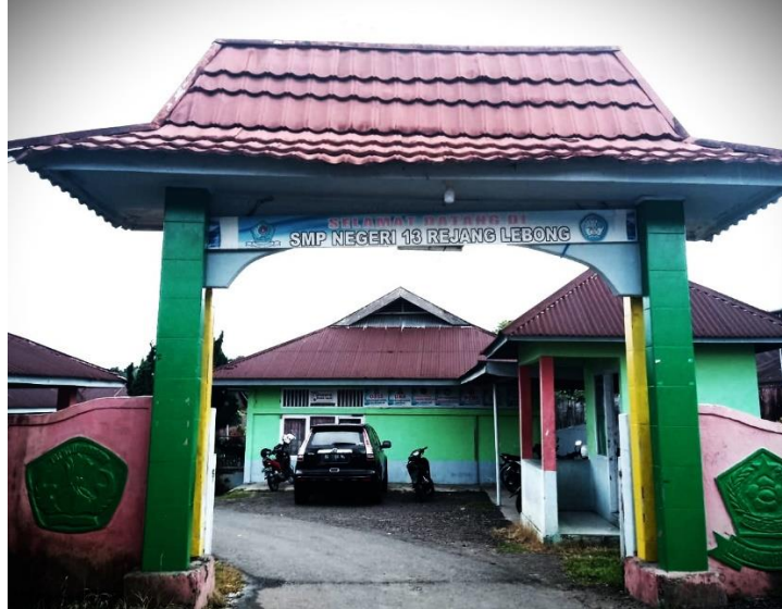
Dokumentasi Lokasi SMP Negeri 13 Rejang Lebong
