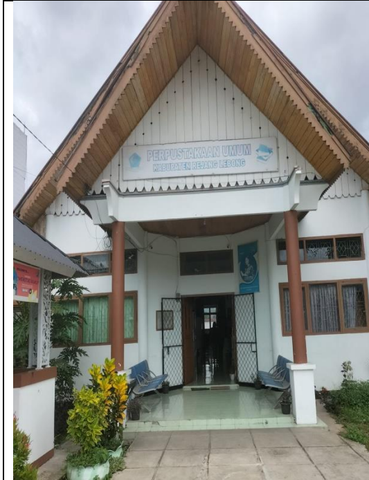
Gedung Dinas perpustakaan dan arsip daerah
