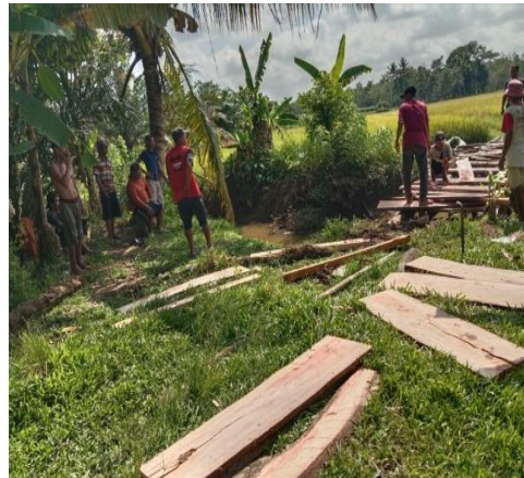
Gotong Royong membuat Jembatan
