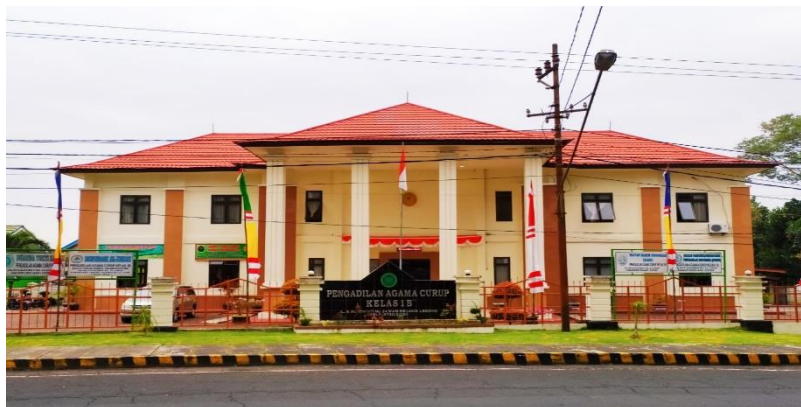
Gedung Pengadilan Agama Curup
