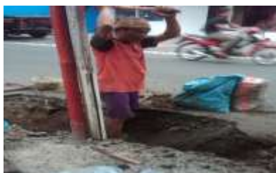
Pekerja galian kabel
