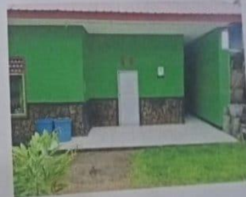
SUMBER DOKUMENTASI WC SEKOLAH
