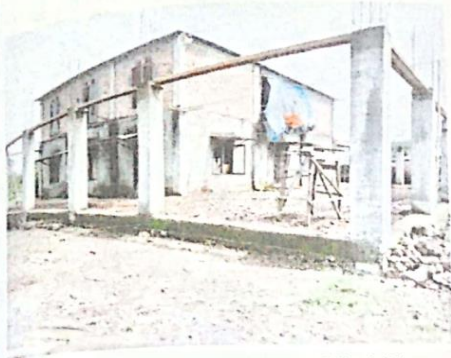
Proses pembangunan masjid tahfidz
