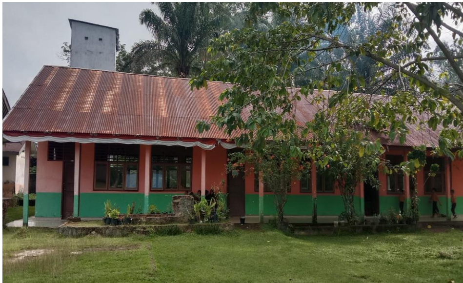
Dokumentasi bangunan ruang kelas SDN 2 Wonosari
