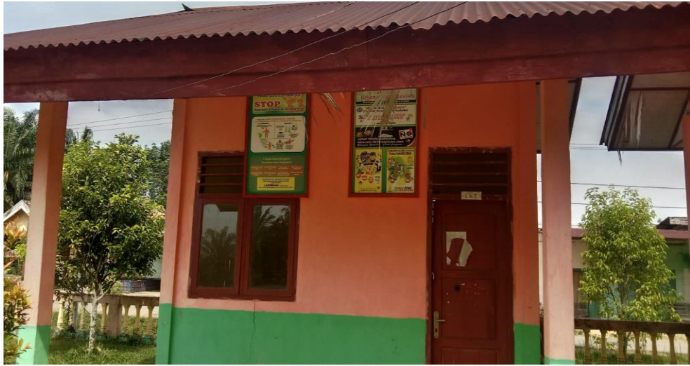
Dokumentasi bangunan UKS SDN 2 Wonosari
