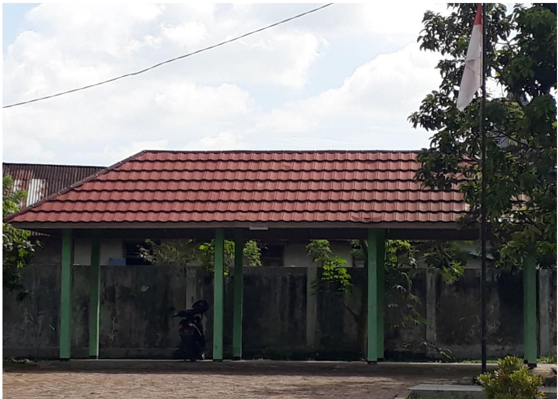
Ruang Parkir SLBN I Rejang Lebong
