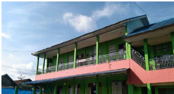
Foto disamping untuk lantai 2 itu merupakan ruangan kepala sekolah dan lantai 1 terdapat mushola
