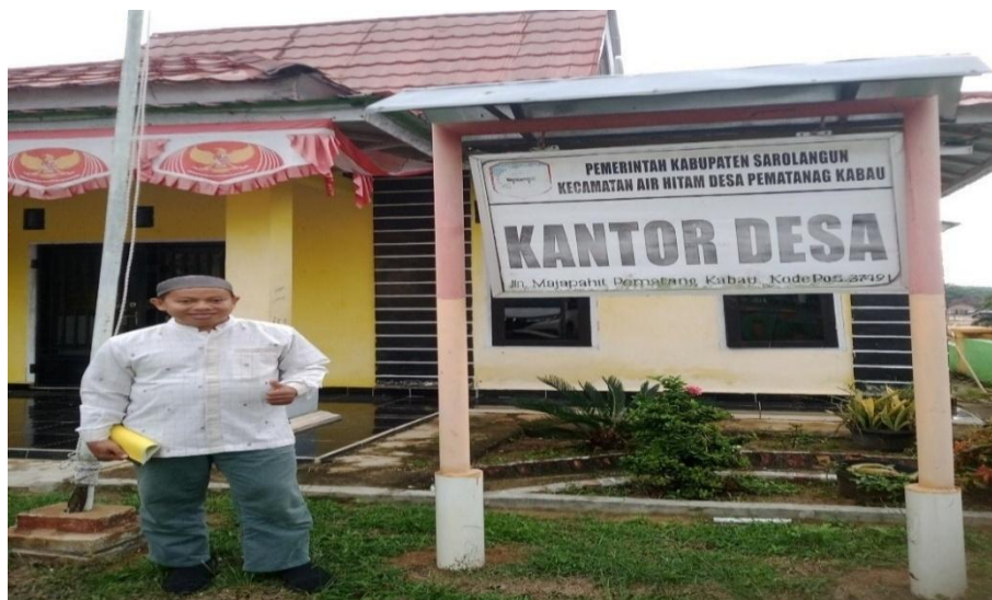
4.11. Foto di kantor Desa Pematang Kabau Kecamatan Air Hitam Kab.Sarolangun
