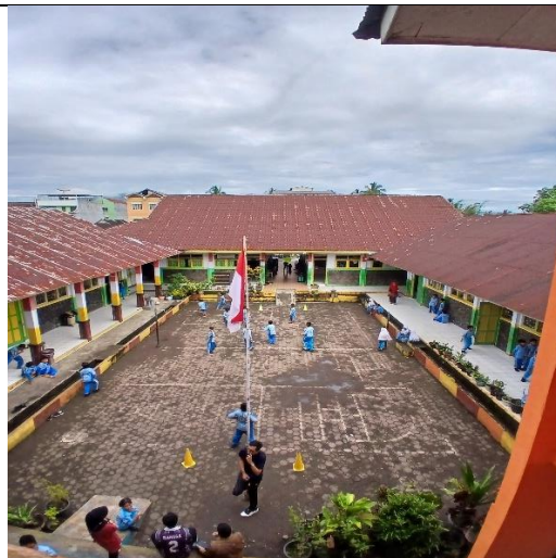
Kondisi SDN 01 Rejang Lebong
